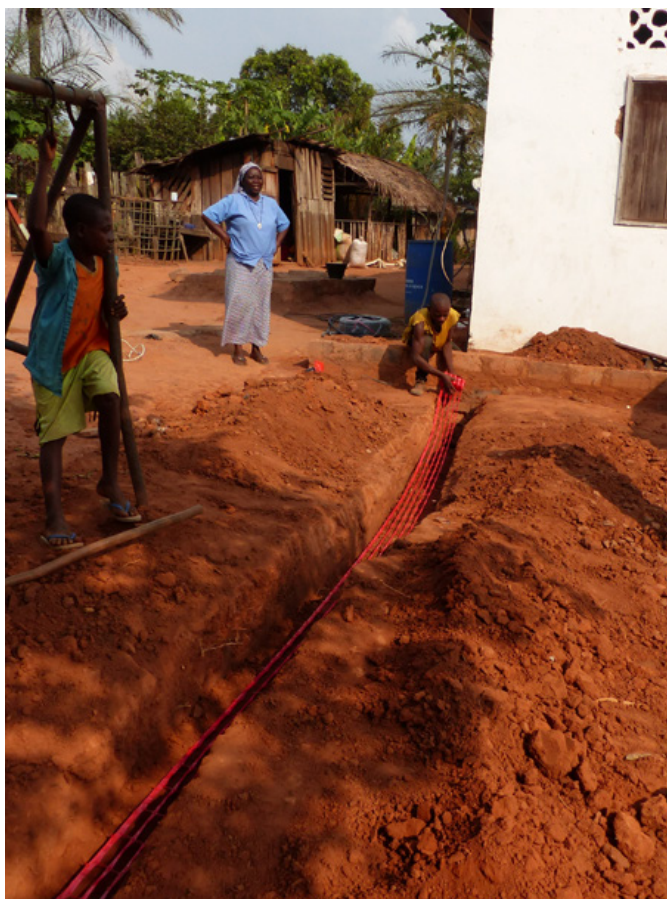
Les câbles électriques entre le centre de santé et le local des sœurs sont enterrés au fond d'une tranchée
