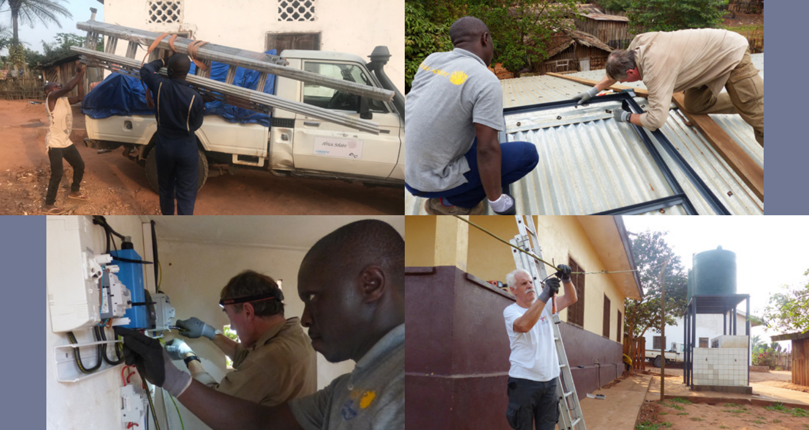
Le début des travaux à Enyellé
