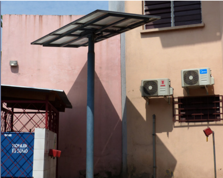
Deux panneaux solaires pour pomper l'eau au centre de santé Sainte Rita
